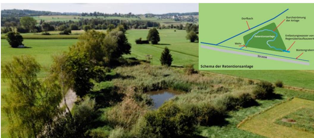
Abbildung 27: Schilf-Retentionsanlage in Geuensee (LU). Die multifunktionale, naturnahe Anlage dämpft Abflussspitzen bei Hochwasser, reichert Grundwasser an und dient als wertvolle Biotopfläche für die heimische Artenvielfalt. Durch die einfache Bauweise und den minimalen Unterhalt sind Schilf-Retentionsanlagen eine kostengünstige Alternative zu herkömmlichen Lösungen. Bildquelle: Gemeinde Geuensee; seecon gmbh
