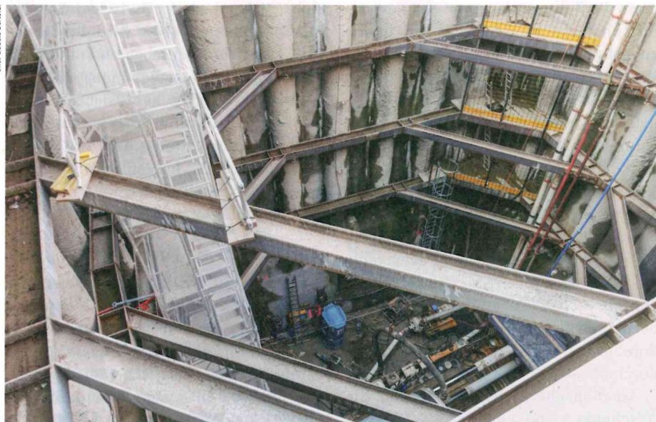
Der Schacht Milchbuck ist rund 20 Meter tief und stellt im Grundriss ein Sechseck dar. Im obersten Teil des Schachts wird nach Ende der Bohrarbeiten die Verteilkammer Milchbuck platziert.
